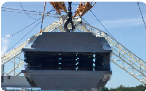
Abb. 3: Hebevorrichtung für Federelement mit Ringschraube
