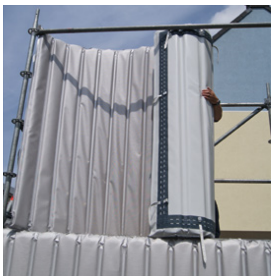
Extender en el vano del andamio
