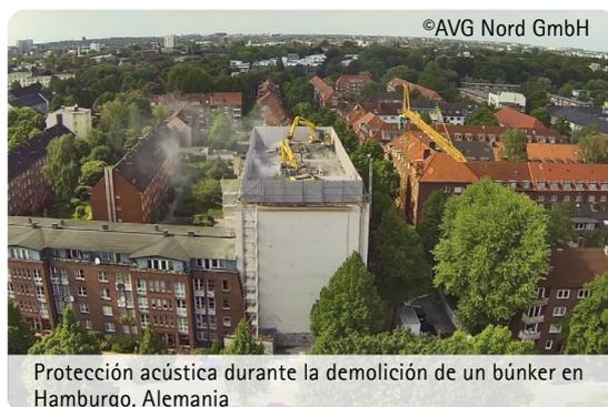
Protección acústica durante la demolición de un búnker en Hamburgo, Alemania
