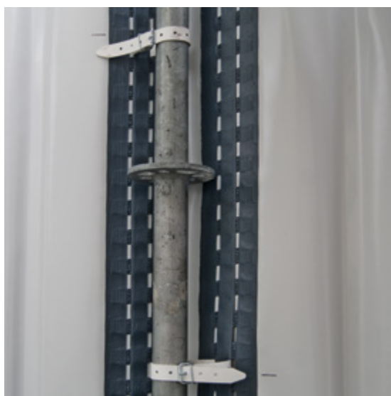
Figura 5: Alineación, sujeción al poste del andamio
