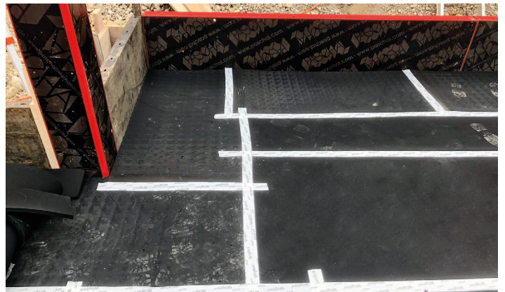
Viviendas unifamiliares en Gräfelfing, instalación de Cibatur® en una y dos capas bajo la losa de cimentación
