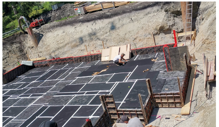
Vivienda adosada en Gröbenzell, instalación de Cimax® bajo los muros de carga debido al agua freática
