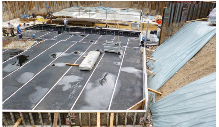
Edificios residenciales en Bauseweinallee, colocación de Cibatur® en una y dos capas
