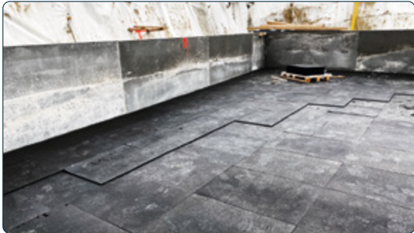
Montaje en varias capas bajo la losa de cimentación
