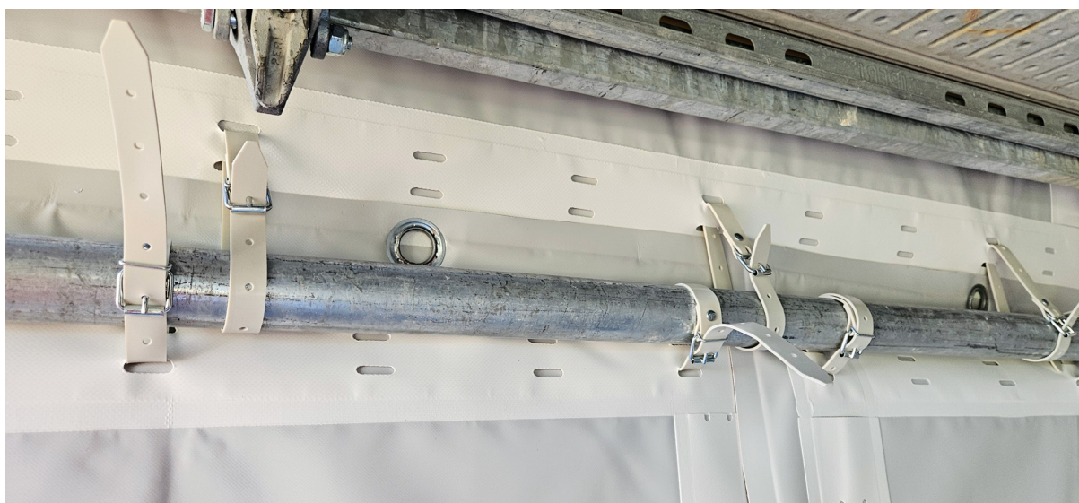
Figura 3: Fijación en larguero del andamio, solape superior
