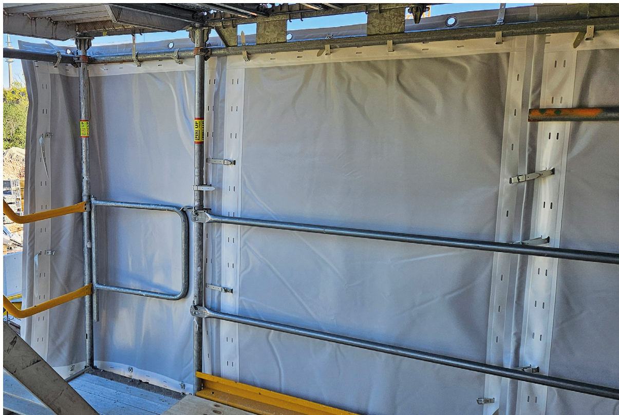
Figura 4: Fijación en el montante del andamio, unión de los elementos Cisilent en el centro del campo
