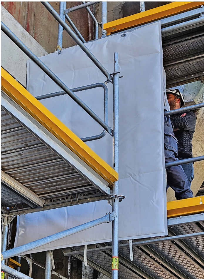
Figura 2: Inicio del montaje, alineación
